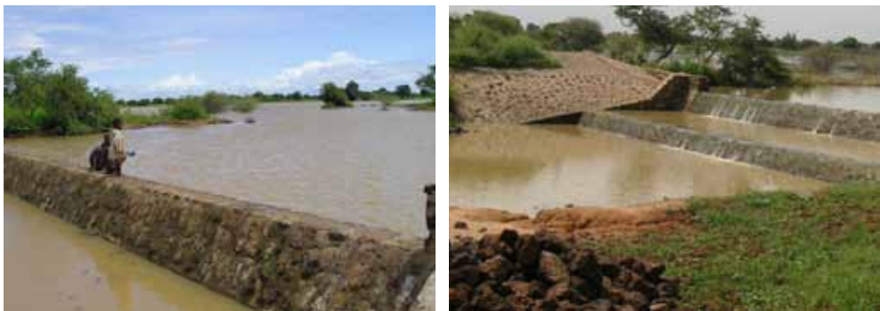
Figure 35. a) De l'eau dans un barrage déversant; b) Un barrage déversant à Kalfou (région de Tahoua, au Niger) (Photos: GIZ / Aboubacar Mounkaila).
