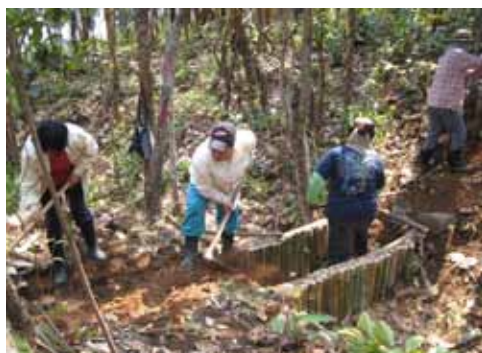
Figure 18. a et b. Les villageois ont construit un barrage de retenue basique dans l'une des petites rivières, avec des matériaux locaux. (Photo : Institut d'hydro et agro informatique de Bangkok (HAI)).
