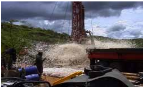
Figure 24. Forage de points d'eau profonds, afin d'accroître l'accès à un plus grand volume de réserves d'eaux souterraines stockées.
