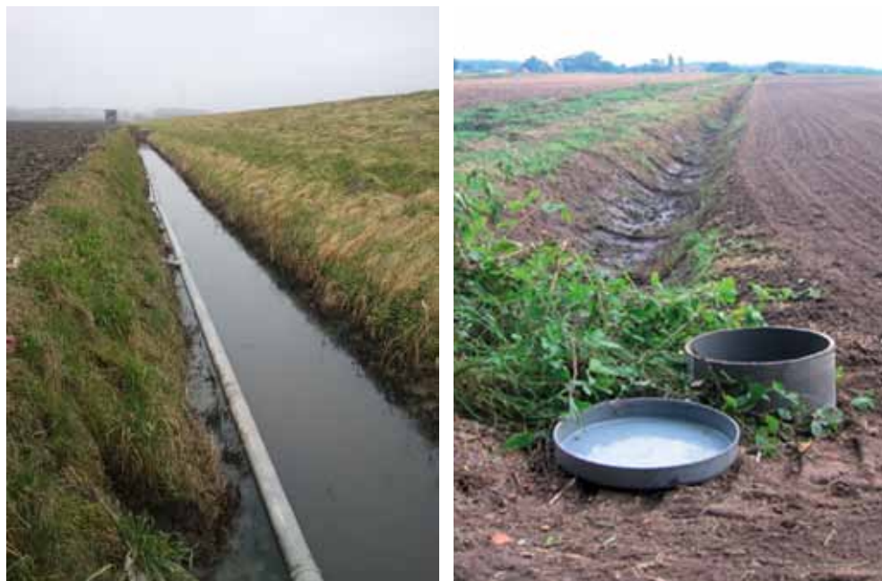
Figure 32. a) Drainage contrôlé installé dans les champs aux Pays-Bas, où les drains sont reliés à un drain collecteur; b) et à un tuyau vertical agissant comme unité de commande du niveau de l'eau. (Photo: Acacia Water).
