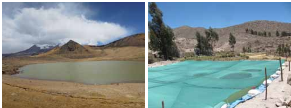
Figure 42. a) Étang de stockage en haute altitude; b) Bassins ouverts recouverts pour la mise en réserve de l'eau de source (Photos: Acacia Water).
