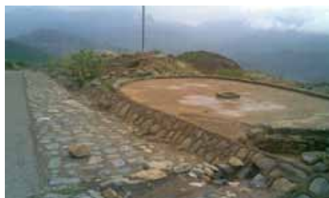
Figure 46. Collecte des eaux de ruissellement du réseau routier dans une citerne (Yémen) - le premier flot est rejeté car il est contaminé (Photo : Mohammed Al Abayad)
