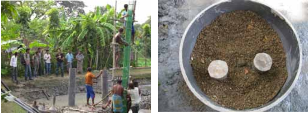
Figure 29. a) Construction d'un puits; b) Puits d'infiltration typique.
