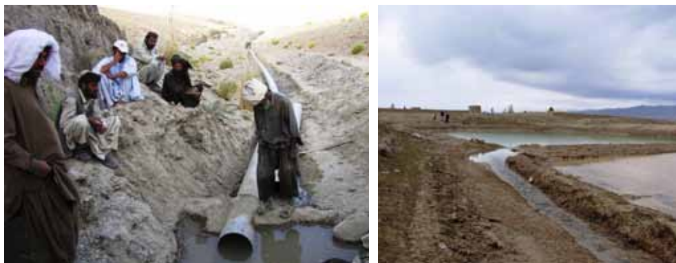
Figure 22. a) Les villageois prennent une pause, pendant les travaux d'amélioration du système de karez de Qilla Iskan Khan. Ils installent un tuyau d'infiltration en PVC de 30 cm de large à l'intérieur du karez; b) Le réservoir en géo-membrane (Photo : UICN Pakistan, 2011 et 2010).
