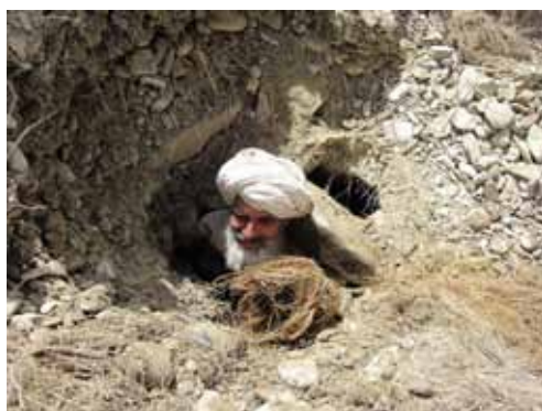
Figure 20. Un nettoyeur spécialisé dans les Karez, à Qila Iskan Khan, sortant avec une touffe d'herbe retirée du lit du canal souterrain. Le karez étant rempli d'eau, les nettoyeurs retiennent leur souffle lors de l'exploration. En raison des risques élevés et des compétences particulières requises, le nettoyage de Karez est un emploi bien rémunéré (Photo : UICN Pakistan, 2010).
