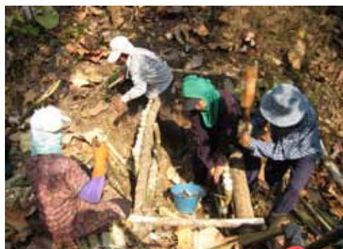
Figure 18. a et b. Les villageois ont construit un barrage de retenue basique dans l'une des petites rivières, avec des matériaux locaux. (Photo : Institut d'hydro et agro informatique de Bangkok (HAI)).
