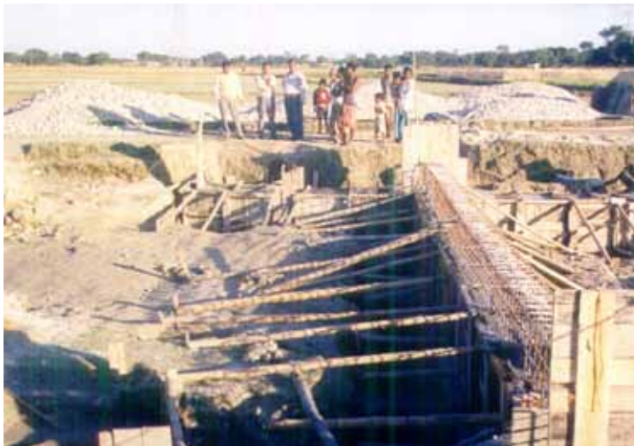
Figure 34. Construction d'un colmatage de ravine pour conserver les eaux souterraines (Photo : Richard Soppe).
