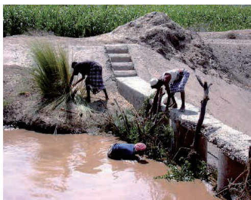
Pemblokiran pintu pembilas ( scour sluice ) pada sistem irigasi serentetan modern di Yaman. (spate-irrigation.org)
