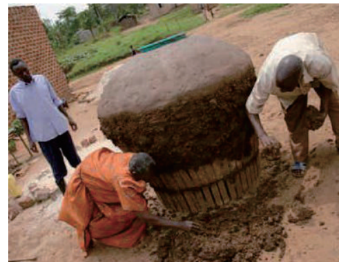
Beberapa orang membangun tempayan Pengumpulan air di rumah mereka di Uganda (WaterAid/Caroline Irby)
