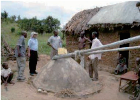
Atap organic dengan penutup plastik tambahan dan tangki yang sebagian berada di bawah tanah di pedesaan Uganda (Danert danMotts,2009)
