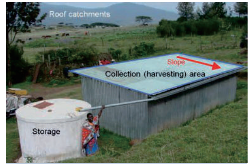
Tangkapan Atap di Kenya menunjukkan perbedaan komponen pada sistem Pengumpulan air atap (M.Malesu).
