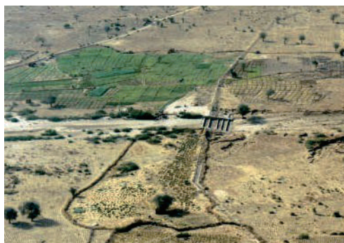
Bendung penyebar air di Sahel. (H. Bender)
