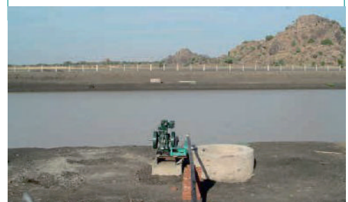
Galian kolam (sistem hafir yang baik) dengan pompa air dan tangki sedimentasi. (Departemen Sumber Daya Air dan Irigasi Sudan dan Sudan Selatan, 2009)
