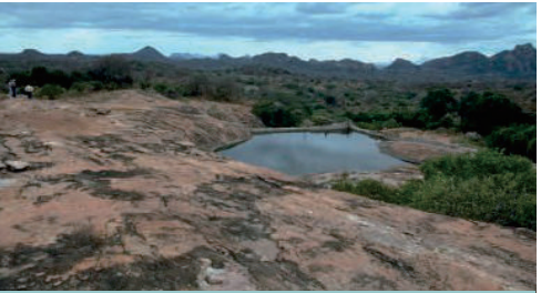
Bendungan tangkapan batu di Kitui, Kenya. (HP.Liniger)
