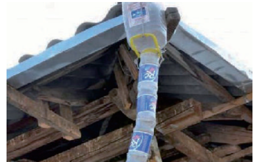
Pengalir yang terbuat dari botol plastik bekas yang dijahit dengan menggunakan kawat tipis S.Stevenson)
