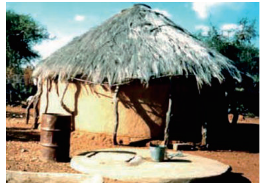
Sistem Pengumpulan air atap yang mengumpulkan air dari atap organik. (www.infonet-biovision.org)
