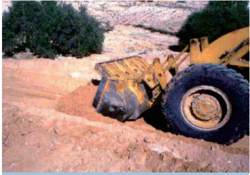
Konstruksi mekanik sebuah parit tabia , Tataouine, Tunisia. (M. Ouessar)
