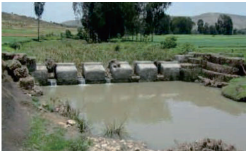
Bendungan yang terbuat dari batu, beton, dan bronjong digunakan untuk irigasi, mengurangi kecepatan limpasan dan meningkatkan rehabilitasi parit. (E. Yazew)
