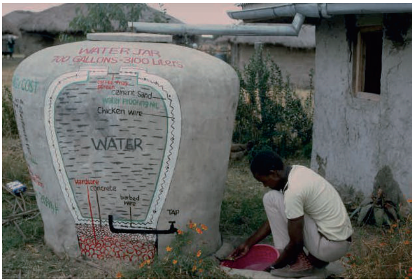
Langkah langkah pembangunan sebuah tangki air semen menggunakan kantong plastik yang diisi dengan jerami. Gambar pada tangki menunjukkan desain dan bahan yang dibutuhkan. (H P Liniger)
