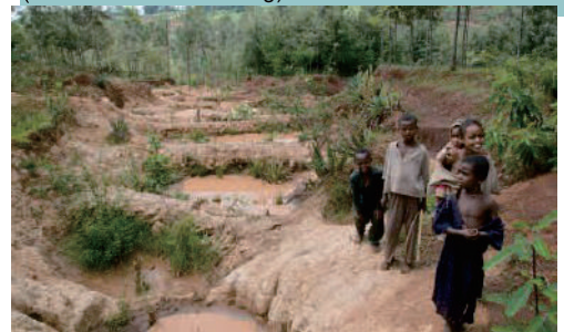
Kolam bendungan pengendali untuk reklamasi parit pada lereng yang landai dan resapan air tanah (HP. Liniger)
