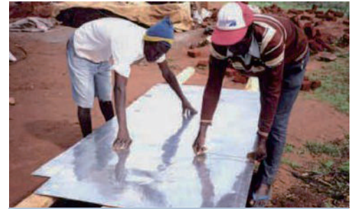
Pembuatan talang air persegi berbahan besi galvanis, dibentuk menggunakan kayu (Nissen-Petersen 2007).
