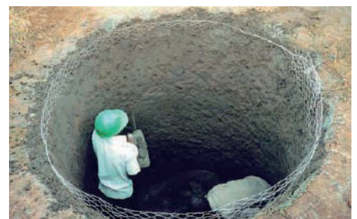
Tangki bawah tanah untuk Pengumpulan air dari halaman dan jalan, Kenya. Tangki ini dilengkapi dengan penangkap lumpur dan digunakan untuk menyimpan limpasan (Nissen-Petersen 2007).
