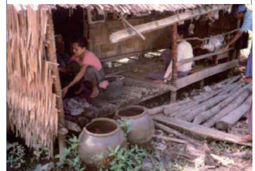
Untuk talang air permanen, penduduk menggunakan bambu yang dibelah dan diikatkan pada beberapa kayu dengan kemiringan pada rusuk rumah.
