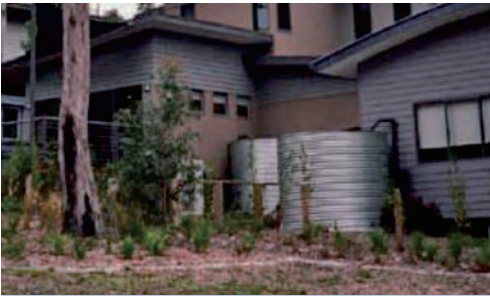
Tangki yang menggunakan lembaran metal di Macquierey Bay,Australia(Barron,2009).
