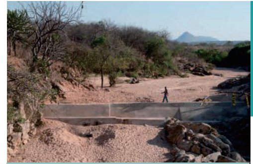
Bendungan pasir di Embu, Kenya. (HP.Liniger)
