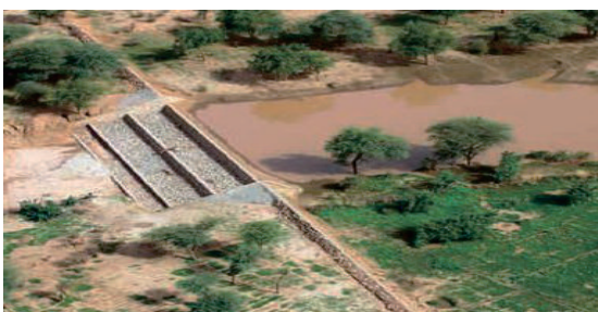
Bendung penyebar air di Sahel (GIZ, 2011).
