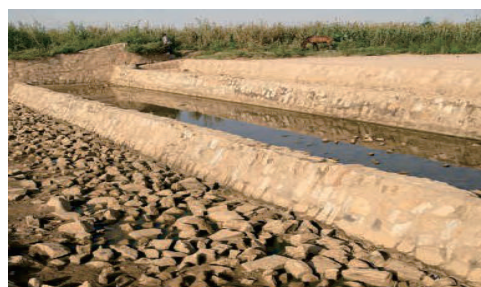
Bendung penyebar air dibangun dalam rangkaian (GIZ, 2011).
