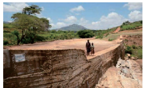
Bendungan pasir terisi penuh di lembah Nzyaa Muysio di Kenya (P. Braden)
