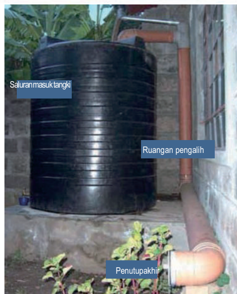
Tangki plastik dengan sistem pembuangan air hujan pertama, Kenya(Stevenson,200 & Doyle,2008).
