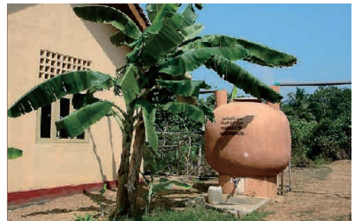
Contoh tangki ferosemen, Sri Lanka (tidak diketahui)
