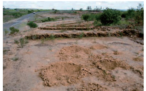
Sistem pemanenan limpasan jalan dengan menggunakan tangkapan makro dan mikro di Etiopia. (HP. Liniger)
