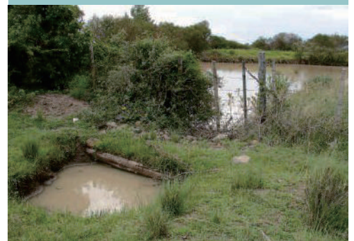
Bendungan kecil dengan penangkap sedimentasi Kenya. (HP. Liniger)
