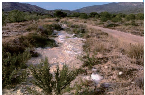
Sistem saluran tradisional ( acequia ) mengarahkan pengecil air banjir (oleh guludan tanah atau batu) dari sungai periodik ke teras almond, Spanyol. (J. de Vente)
