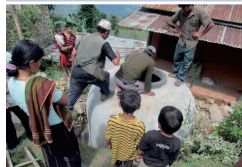
Tangki penyimpanan air hujan sedang dibangun oleh keluarga di Nepal. (RAIN)
