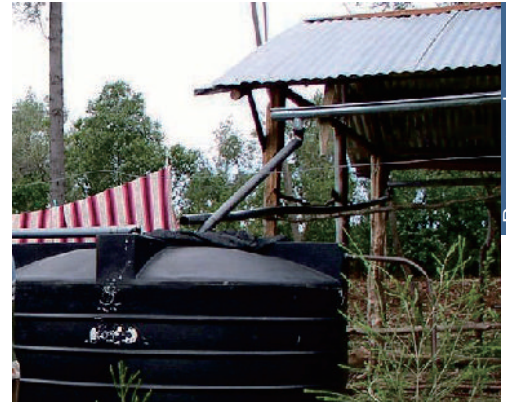
Talang air setengah lingkaran dengan talang air tambahan berbentuk lingkaran. (C.Studer)
