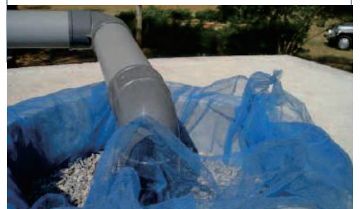
Filter dengan jaring, pasir, dan kerikil yang digunakan di Karnataka, India (Rainwater Club, tidak bertanggung jawab).
