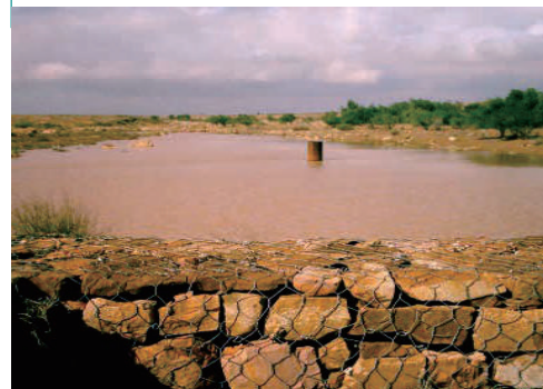
Contoh sumur isi ulang di belakang bendungan pengendali bronjong setelah hujan. (M. Ouessar)
