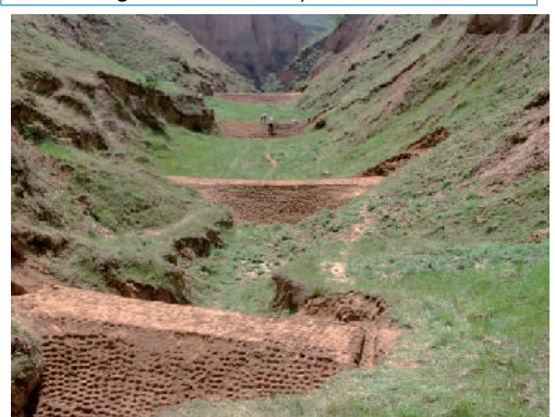
Bendungan warping di wilayah Xifeng, provinsi Gansu setelah pembangunan struktur. (L. Xiaobo)
