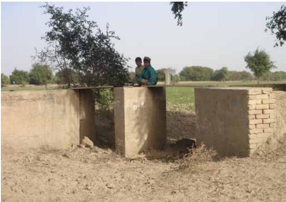
Figure 5: Grandes diguettes utilisées dans l'irrigation par épandage - aménagées par les codétenteurs des terres (Crédit photo: MetaMeta).
