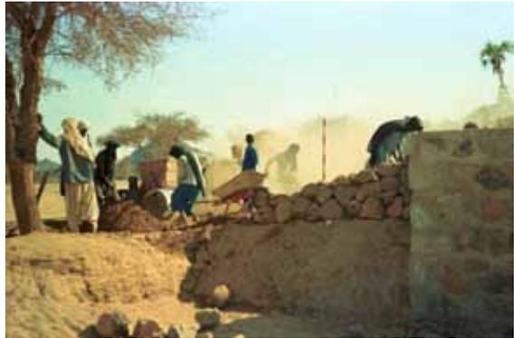
Figura 2: Construcción de las obras de desviación
