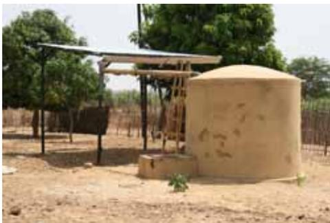
Figura 2. Un hangar construido por la organización asociada CCF, ya que no se contaba con techos disponibles para una recogida de agua de lluvia de los techos.
