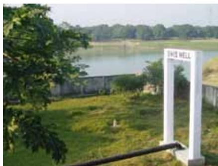
Figura 3: Pozo de infiltración en las orillas del río en Bangladesh, para un suministro de agua libre de arsénico
