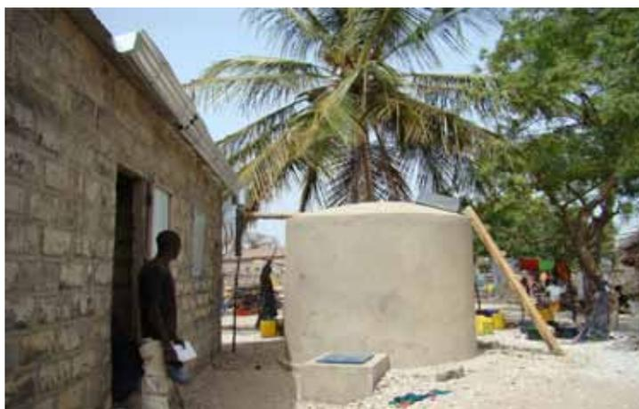
Figura 3. Un tanque de recogida de agua de lluvia en mantenimiento en la aldea de Diogane
