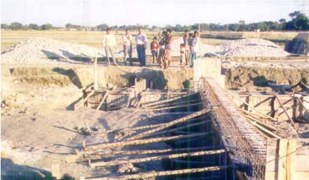
Figura 2: La construcción de un tapón de cárcavas para retener las aguas subterráneas
