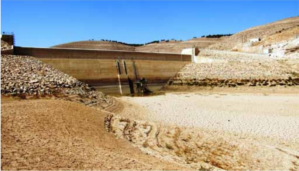
Figura 3: La acumulación de sedimentos en el fondo de la represa de Wadi Wala provocó la obstrucción del desagüe del fondo y la cañería de desagüe inferior.
