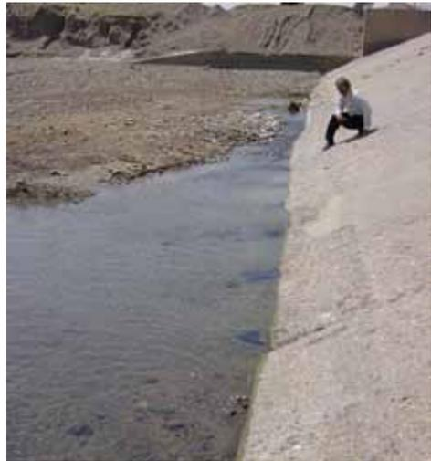
Figura 3: Agua fluyendo de los orificios de desagüe
