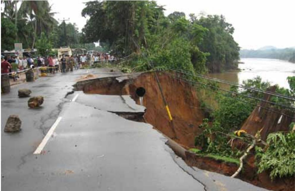
*Figura 1. Erosión de los márgenes del río Kelani debido a la extracción de arena. Una cañería de abastecimiento doméstico de agua bajo la carretera se dañó y la provisión de agua a la ciudad se vio afectada durante varios días (Foto: Badra Kamaladasa, Departamento de Riego de Sri Lanka).*
