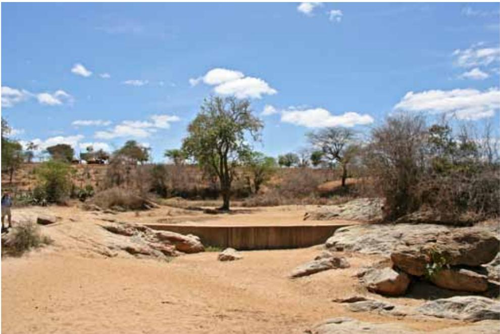
Figura 1: Una típica represa de almacenamiento en la arena durante la temporada seca en el Distrito de Kitui
